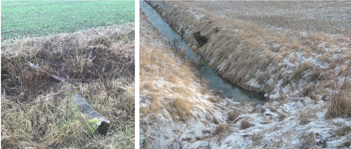
Befintlig trasig trumma vid Harbyvägen Avvattningsdiket från åkern i Täby mot Borgby 1:1.
