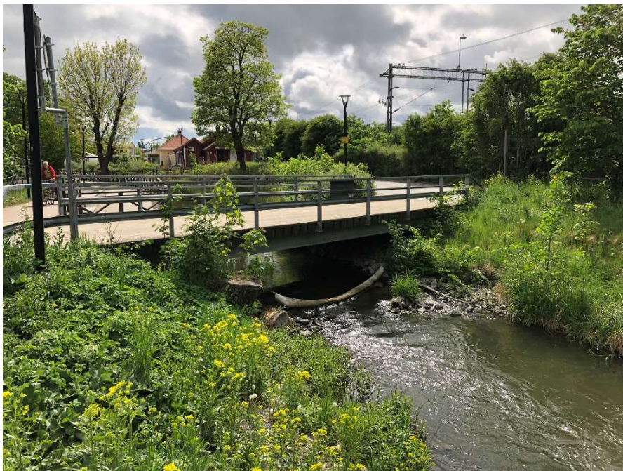
Figur 8. Bro över Väsbyån. Nedan bron ligger en läns.
