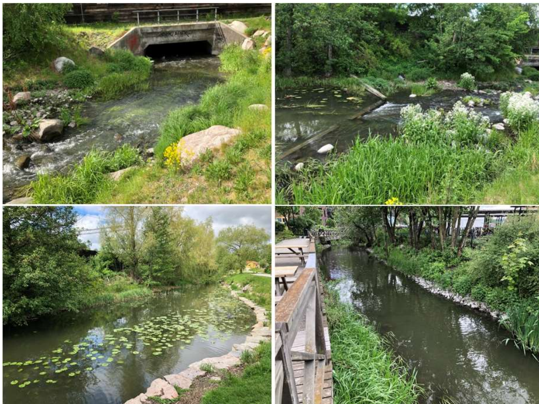
Figur 7. Sträckan mellan järnvägs-kulverten (överst till vänster) och kulverten under busstorget vid Upplands Väsby station rymmer bland annat ett dämme (längst upp till höger) samt föregående spegeldamm (längst ner till vänster). Sträckan fram till kulverten ser till största del ut som bilden längst ner till höger.
