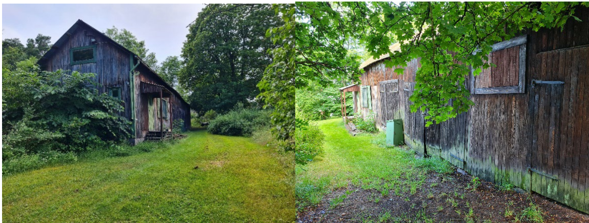
Bild på ladan/ekonomibyggnaden på den västra sidan av fastigheten.
