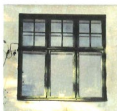
Spröjsat jugendfönster med småspröjsar ovanför tvärposten
